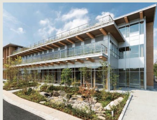
筑波研究所 新研究棟
