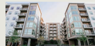
米国Crescent Communities 施工例
