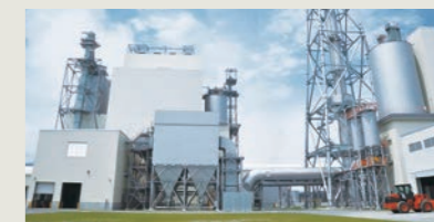
紋別バイオマス発電所
